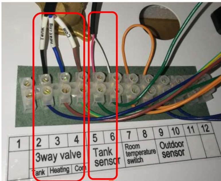
Привод внешнего трехходового клапана
